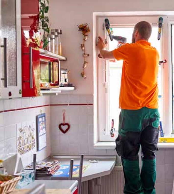
Circa 1.400 finestre, 3 mesi, 6 posatori: la ristrutturazione di 3 case plurifamiliari a Erfurt dimostra come la posa con rivestimento interno del vecchio telaio di Finstral semplifichi notevolmente la sostituzione dei serramenti.
