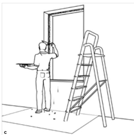
La struttura muraria viene ripristinata (intonacatura e pittura). Se necessario, viene allestito un ponteggio.
